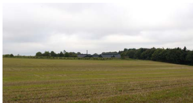
8. Landbrugsbygninger ved Rørbæk, som er fint indpasset i landskabet.
