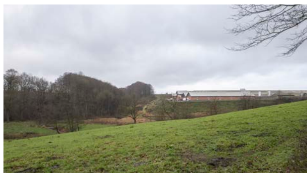
7. Landbrugsbyggeriet ved Rønshave ligger udenfor området, men påvirker oplevelsen af ådalen. Påvirkningen forstærkes af spændet mellem ådalens lille skala og byggeriets store skala.
