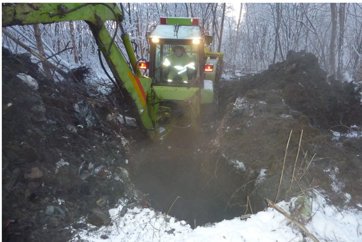
Figur 3 - R1 hvor der graves dybere til 5,0 m u.t.
