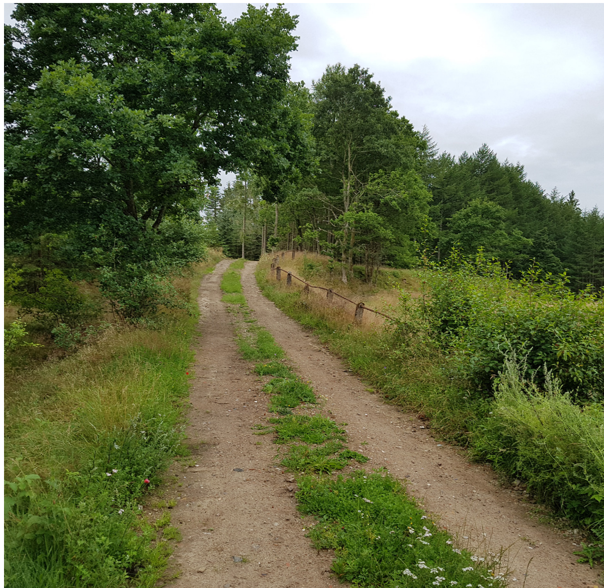
Skovvej passerer jernbanedæmningen
