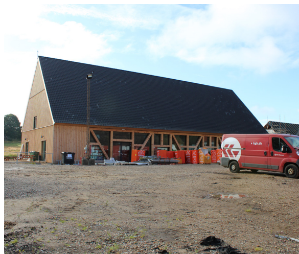
"Agerumsladen" ny undervisningsbygning under opførelse 2020.
