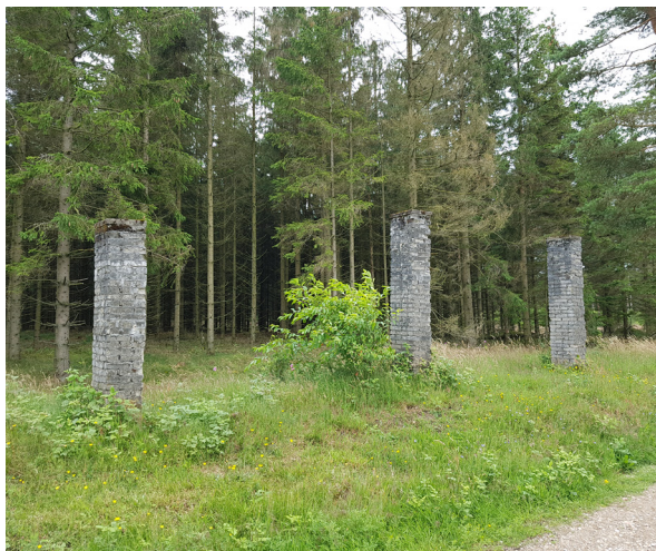
Søjler til benzinledning
