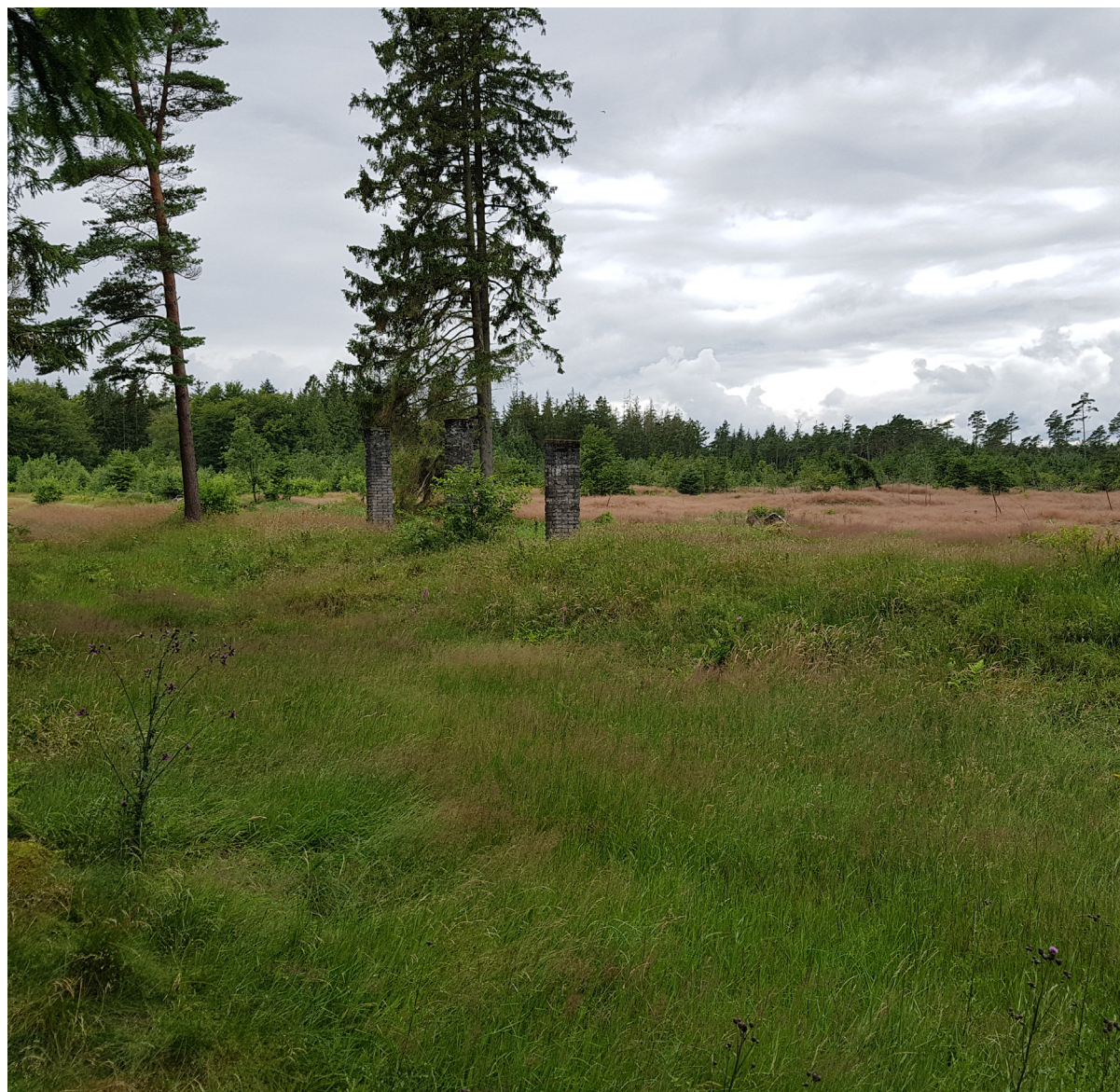
Søjler til benzinledning til flyvepladsen
