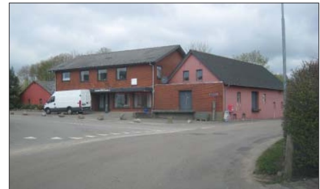
Den tidligere købmandsforretning
