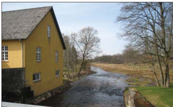
Det vandkraftdrevne tidligere elværk ved Omme Å
